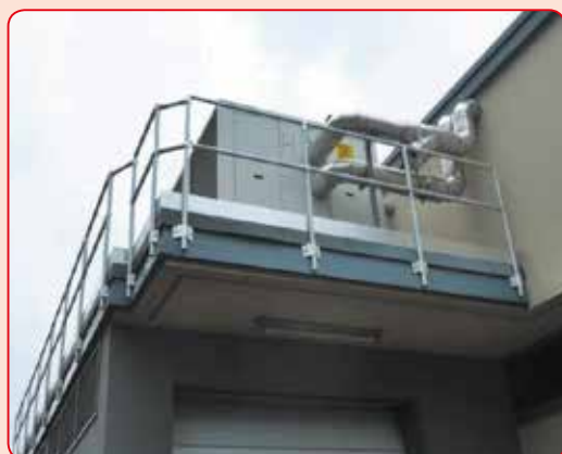
• Esempio di parapetto montato su edificio
